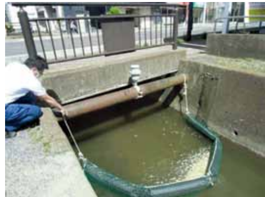
②ごみ回収フェンス設置
