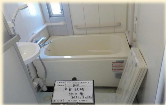
市営住宅におけるバリアフリー化改修工事 (浴室における転倒防止の手すり設置等)
