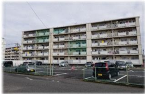
守山市営住宅 久保団地
