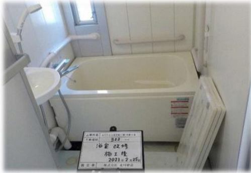
市営住宅におけるバリアフリー化改修工事 (浴室における転倒防止の手すり設置等)
