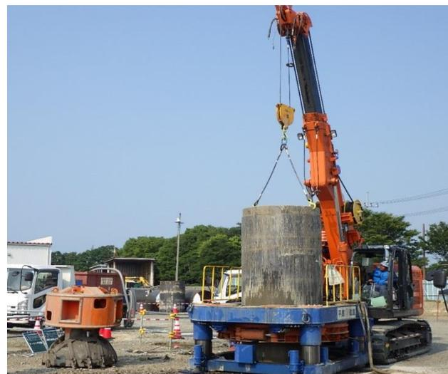
ケーシング（鉄製の筒）を繋ぎ、所定の深さまで専用機械を使用し、打設します。最も大きいケーシングは、単体で長さ3m、直径2mになります。
