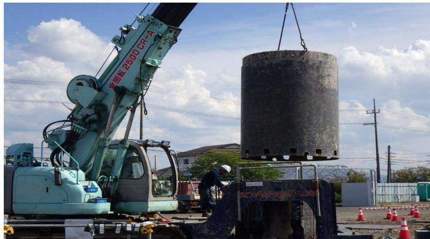
流動化処理土が固まる前に、ケーシングを引き抜いています。
