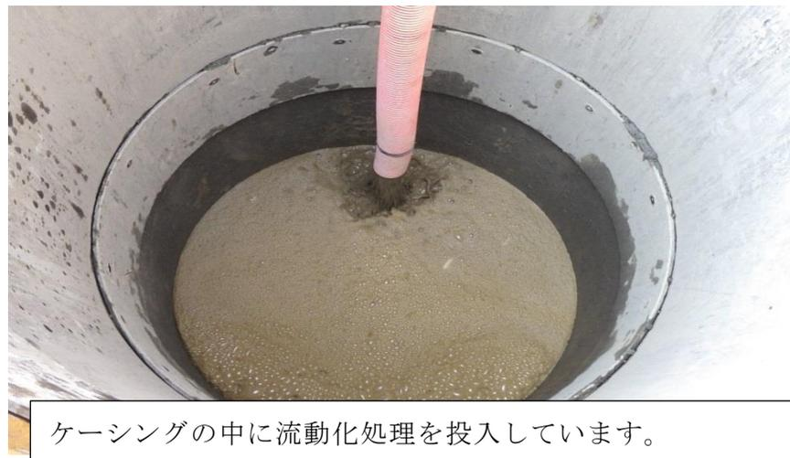
ケーシングの中に流動化処理を投入しています。
