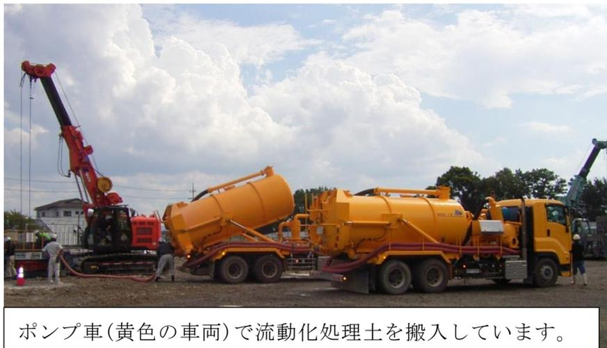
ポンプ車(黄色の車両)で流動化処理土を搬入しています。
