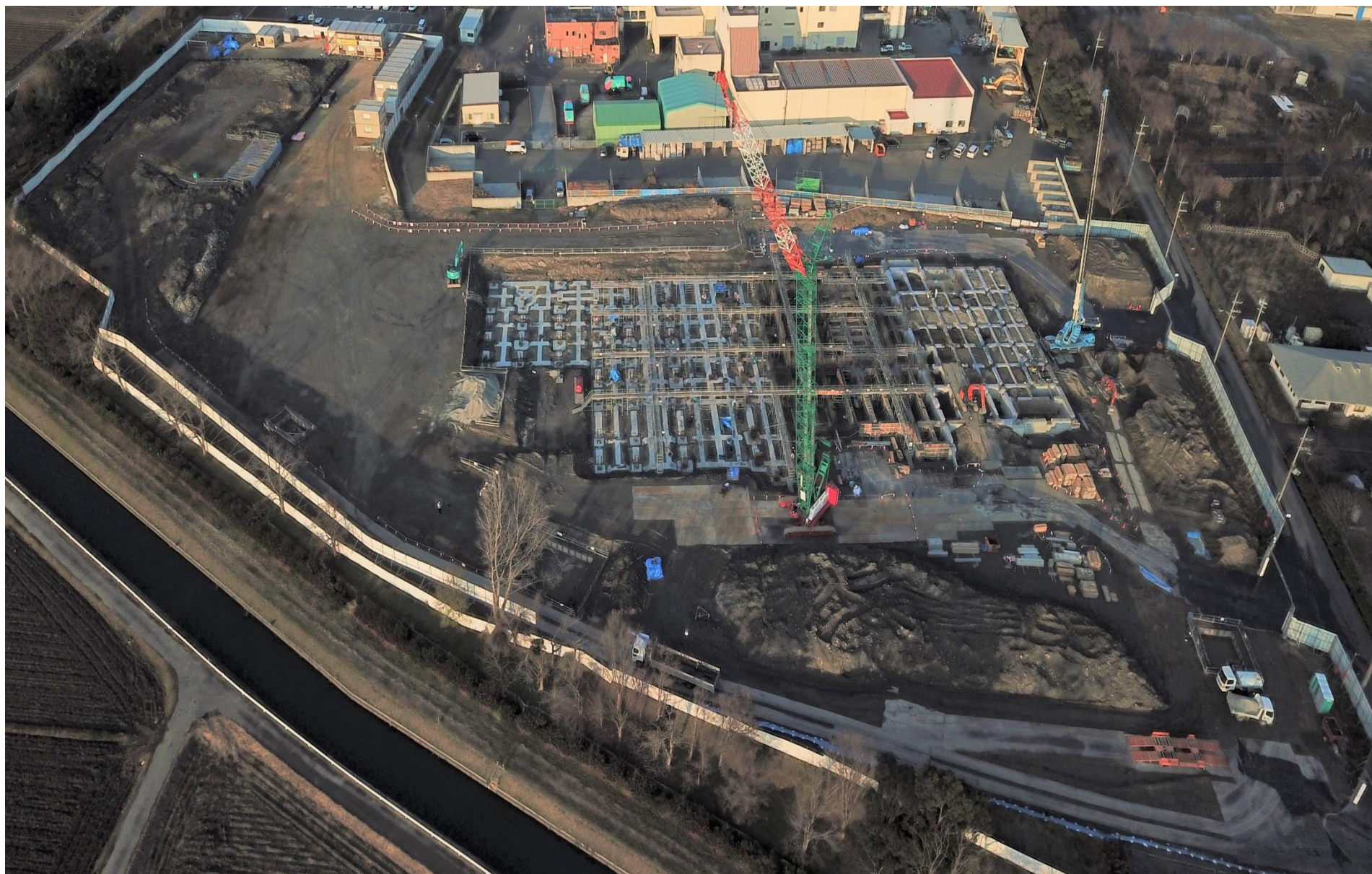
令和元年 12 月（2019 年 12 月）の工事状況 12 月 23 日撮影
