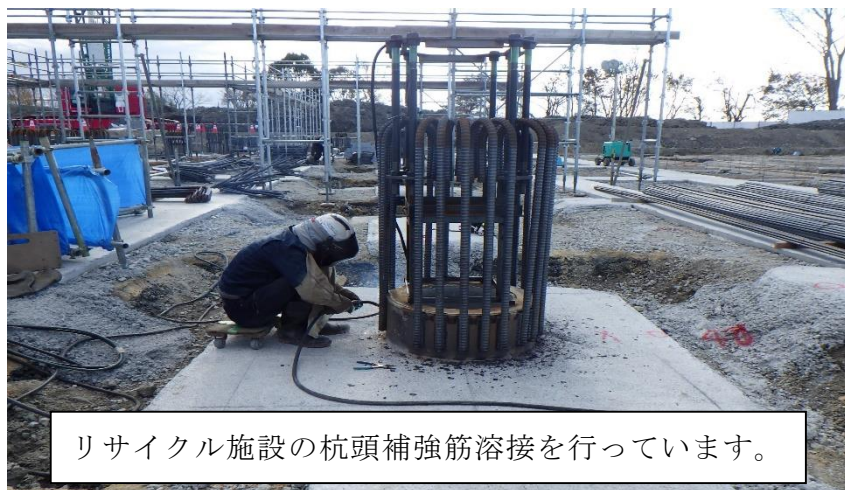
(3) 杭頭補強筋溶接
