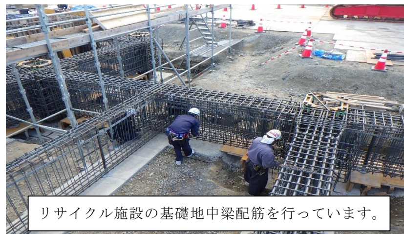
(4) 基礎地中梁配筋
