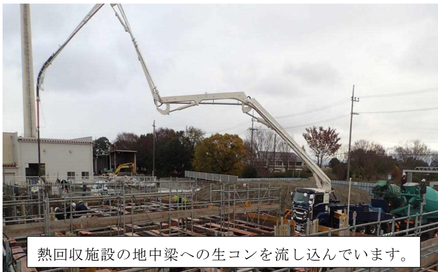
(1) 熱回収施設生コン打設①
