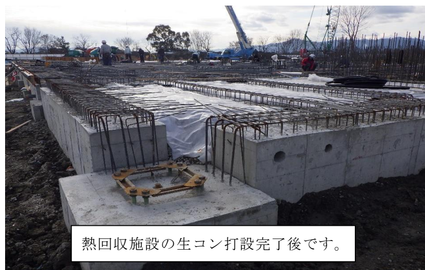
(2) 打設完了後の写真
