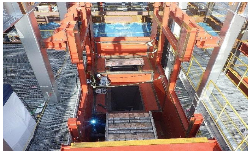
(8) 熱回収施設：ボイラパネル据付中
