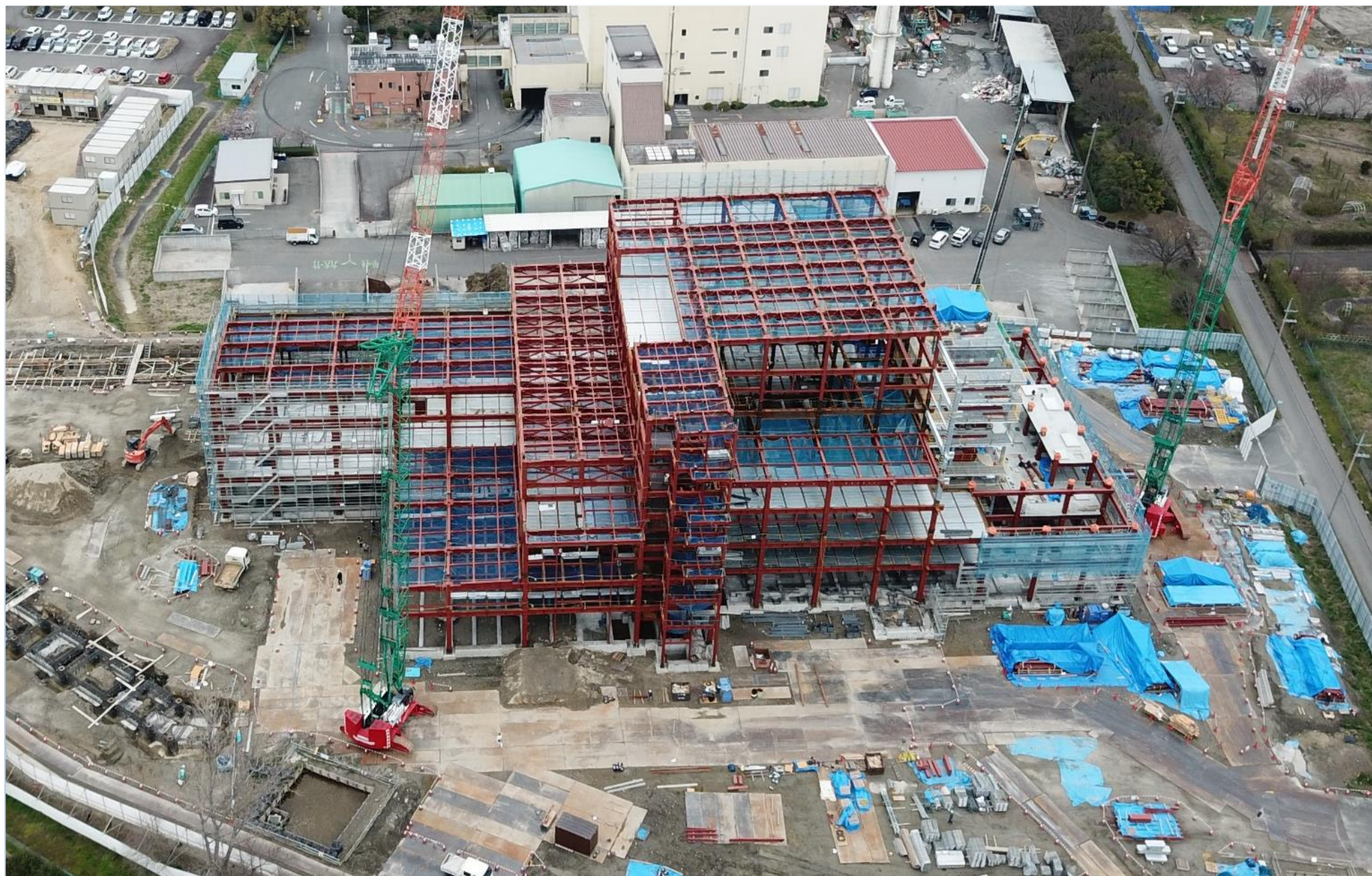
令和2年3月（2020年3月）の工事状況 3月31日撮影
