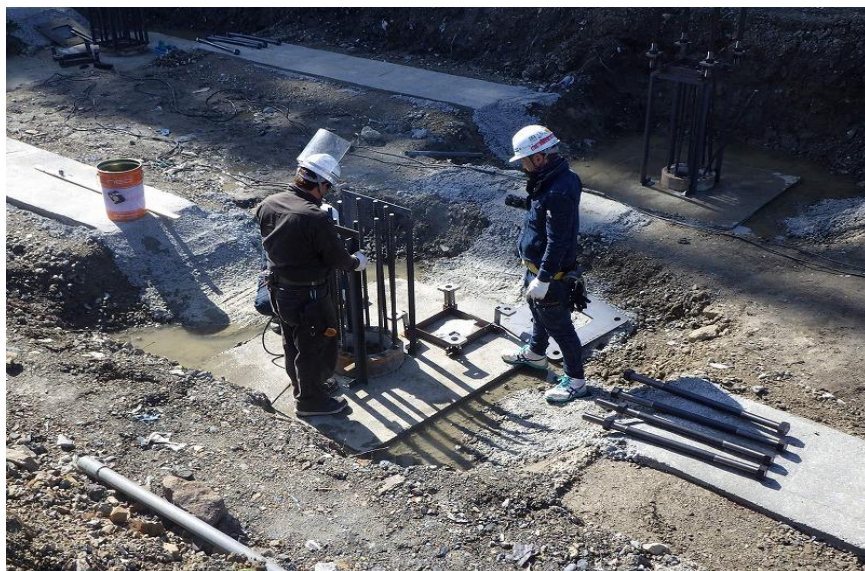
(3) 熱回収施設：ランプウェイ基礎パイルスタッド施工中
