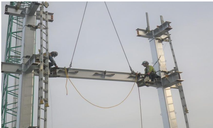
(7) 熱回収施設：ボイラホップ据付中
