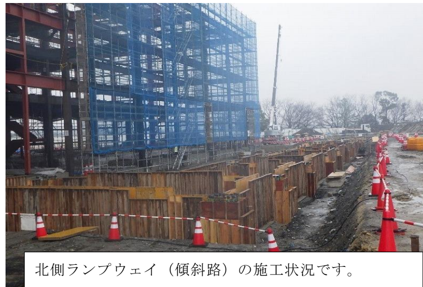
(4) 熱回収施設：ランプウェイ基礎型枠工事
