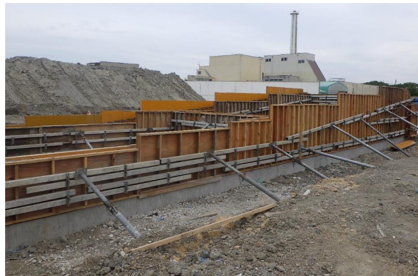
(4) 熱回収施設：ランプウェイ型枠施工後
