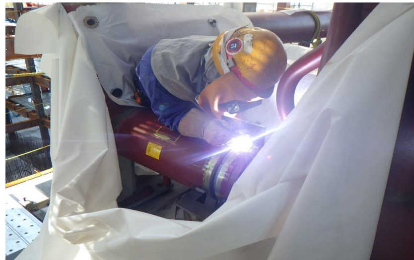
(6) 熱回収施設：ボイラ下部管寄せ溶接中
