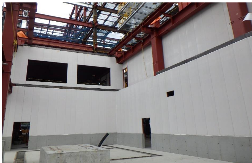
(3) 熱回収施設：1階 ALC 施工後（タービン発電機室）
