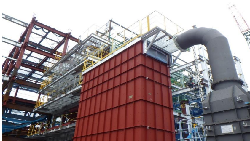
(7) 熱回収施設：ろ過式集じん器据付中
