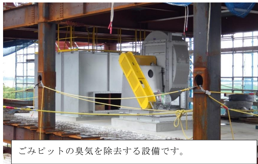
(8) 熱回収施設：脱臭装置据付
