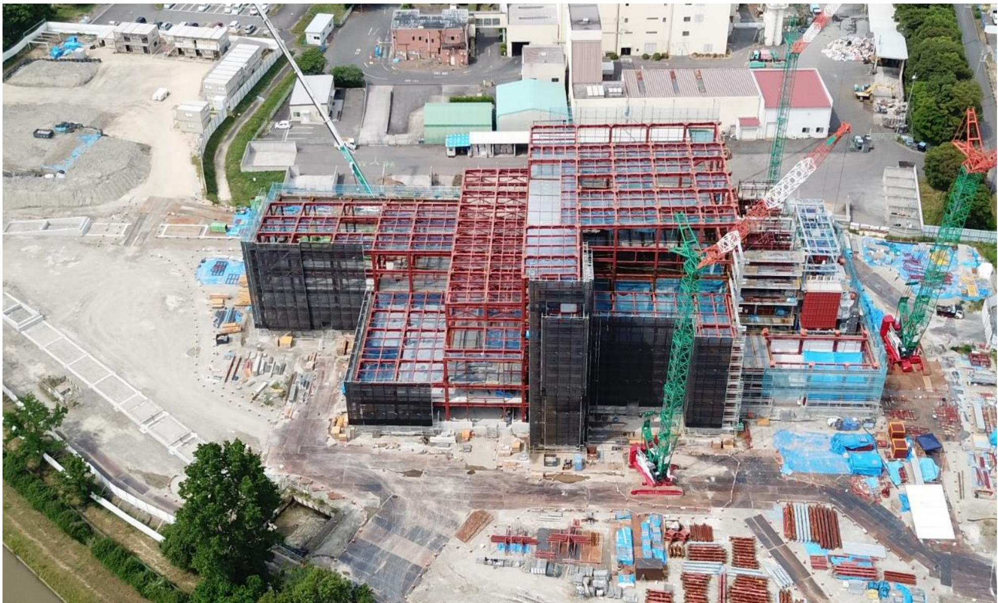
令和2年5月（2020年5月）の工事状況 5月30日撮影
