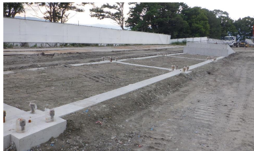
(4) 熱回収施設：ランプウェイ基礎（南側）
