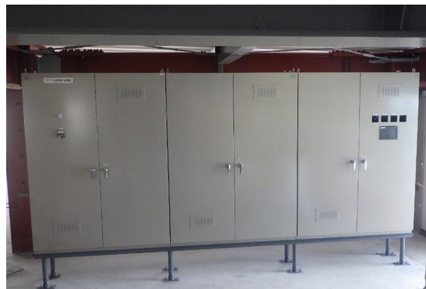
(8) リサイクル施設：動力制御盤（中央制御盤）据付
