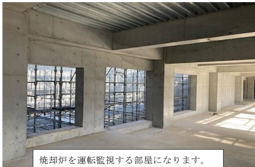
(3) 熱回収施設：中央制御室 床コンクリート打設後
