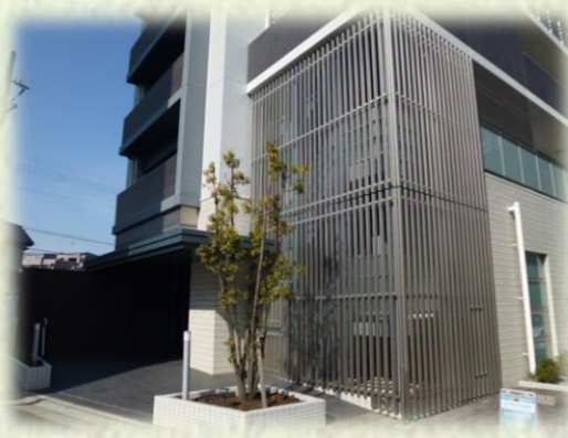
外階段をルーバーにより隠している事例
