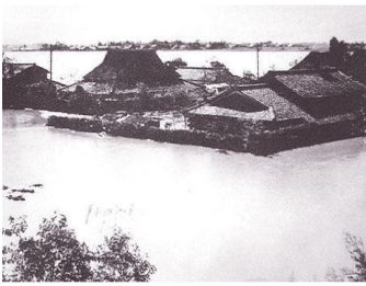
昭和28年洲本町地先の浸水時の様子
