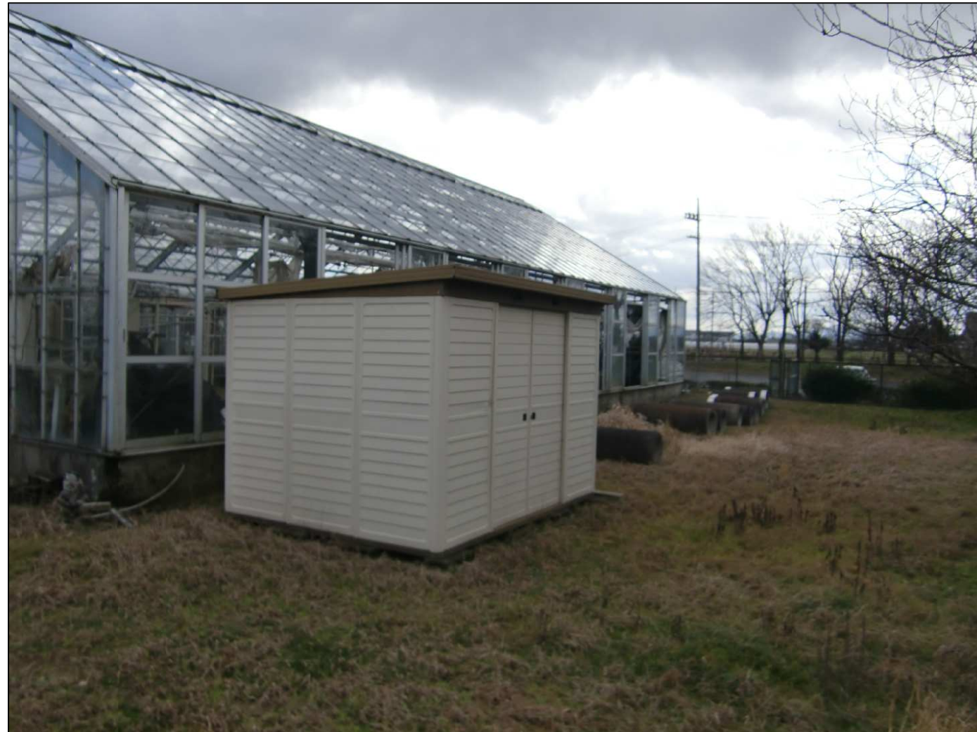
倉庫撤去③
