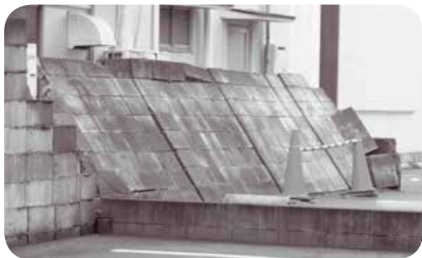
熊本地震で倒壊したブロック塀。こうなる前に早めに安全対策を！
