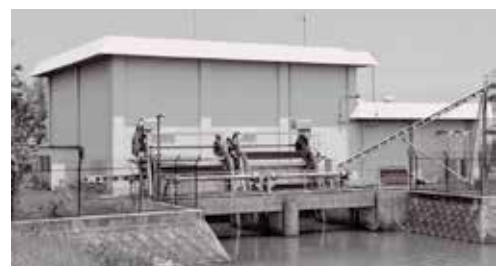
赤野井排水機場
