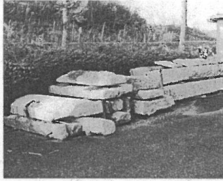
大正年間に野洲川北流から幸津川町の水田を潤すために石製の樋門が設けられた。長さ約4m、の延べ石を箱状に組み、河川の中に埋め込んだもの。
