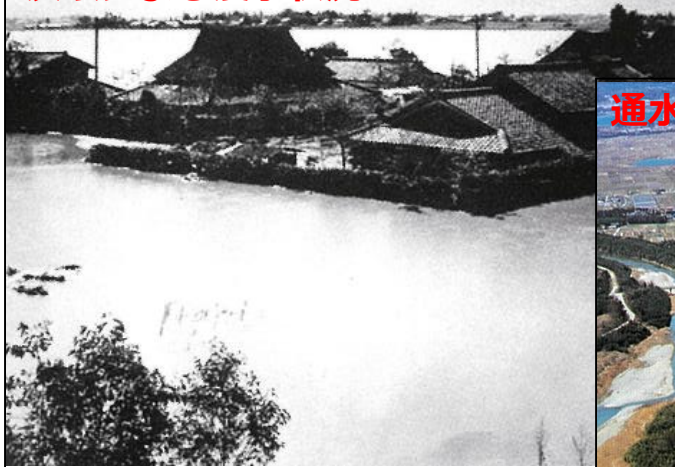
昭和28年台風13号による南流左岸堤決壊による浸水状況
