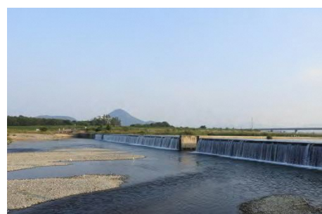
新放水路 落差工から望む三上山
