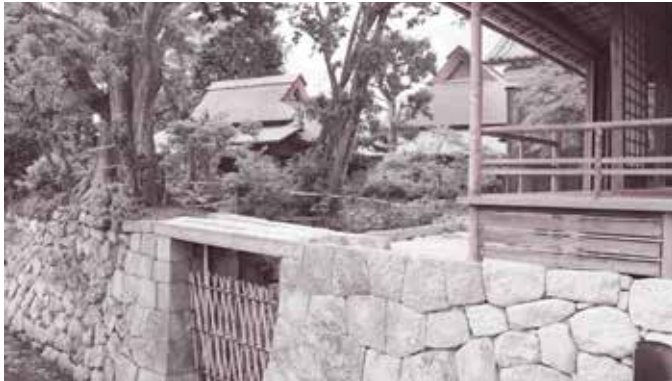
かつて諏訪家屋敷と琵琶湖への水路をつないでいた水門
