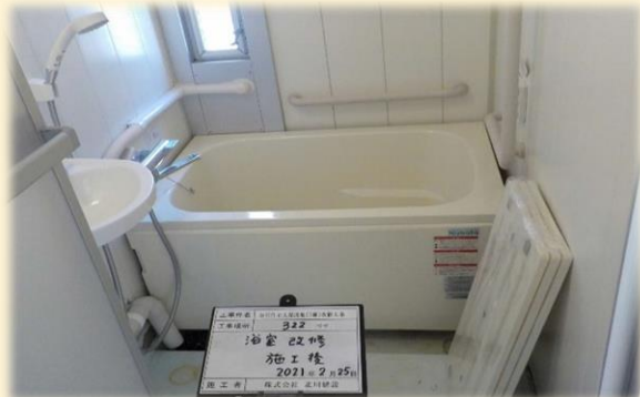
市営住宅におけるバリアフリー化改修工事 (浴室における転倒防止の手すり設置等)
