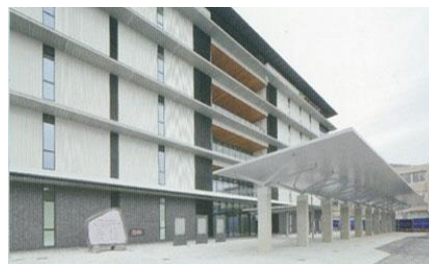
アプローチ前の大きな庇（甲賀市）
