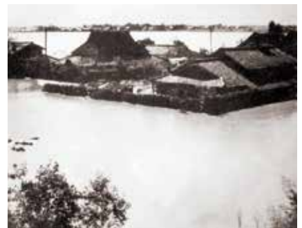
▲堤防が切れた跡・洲本町地先* [1953(昭和28)年9月/台風13号]
