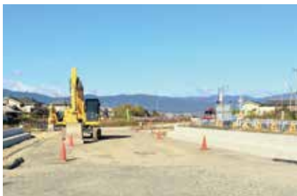
▲新守山川(工事が進む上流部)
