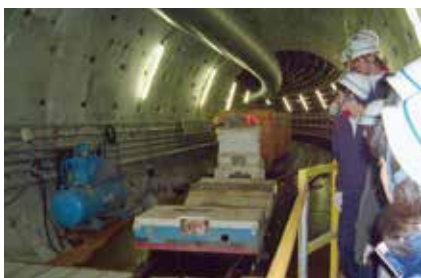
▲雨水幹線建設工事を見学する中学生
