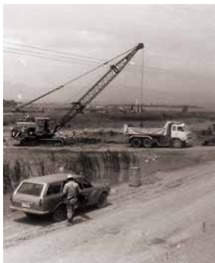
▲改修工事の様子
