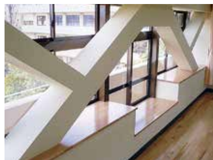
▲耐震補強工事を終えた校舎
