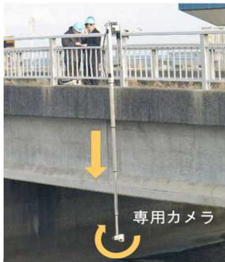
橋梁点検口ポットカメラの活用
