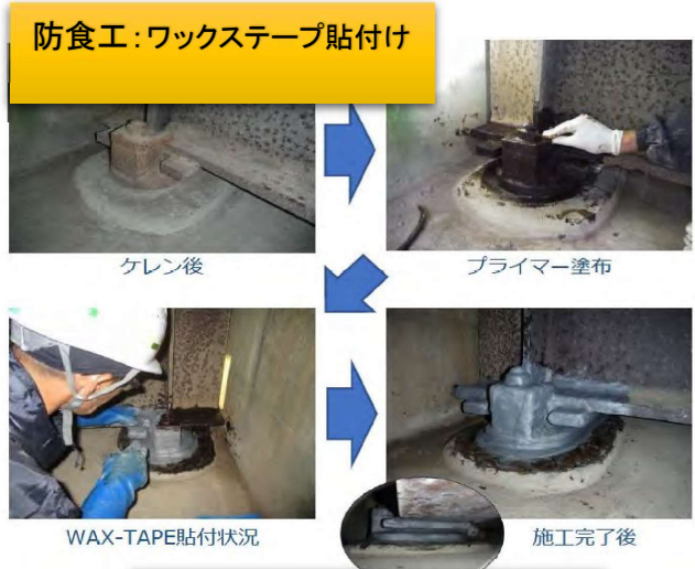
支承防食に新技術の活用
