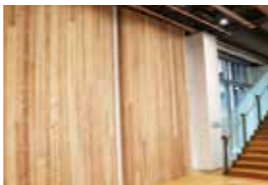
びわこ材(杉)を用いた CLT耐震壁
