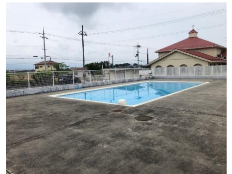
プールサイド状況写真(速野小)
