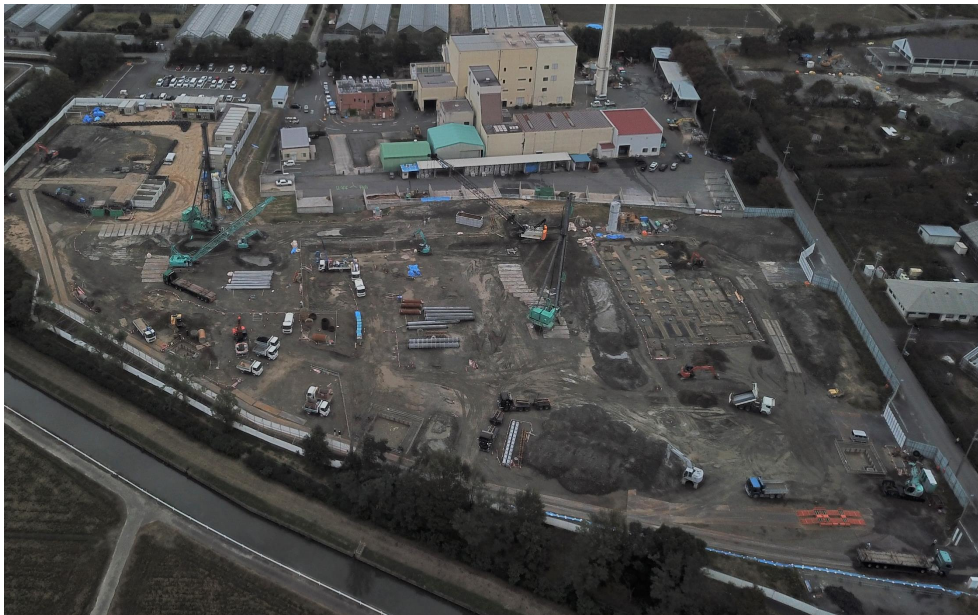
令和元年 10 月（2019 年 10 月）の工事状況 10 月 21 日撮影
