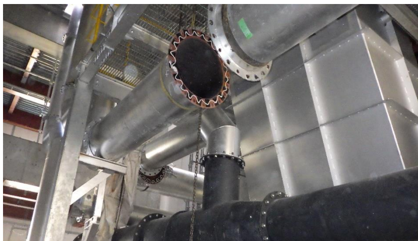
(7) 熱回収施設：ダクト（風道）据付工事
