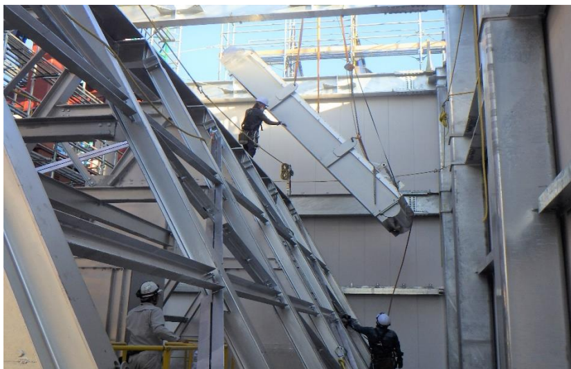
(7) 熱回収施設：ダクト（風道）据付工事
