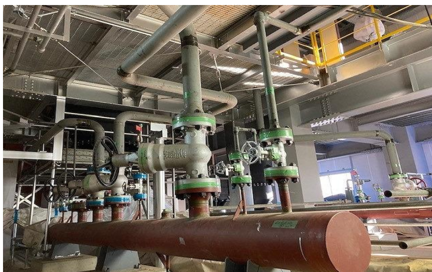
(7) 熱回収施設：高圧蒸気配管工事
