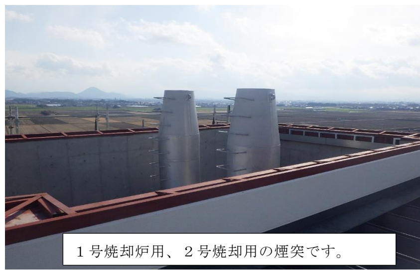
(8) 熱回収施設：煙突据付
