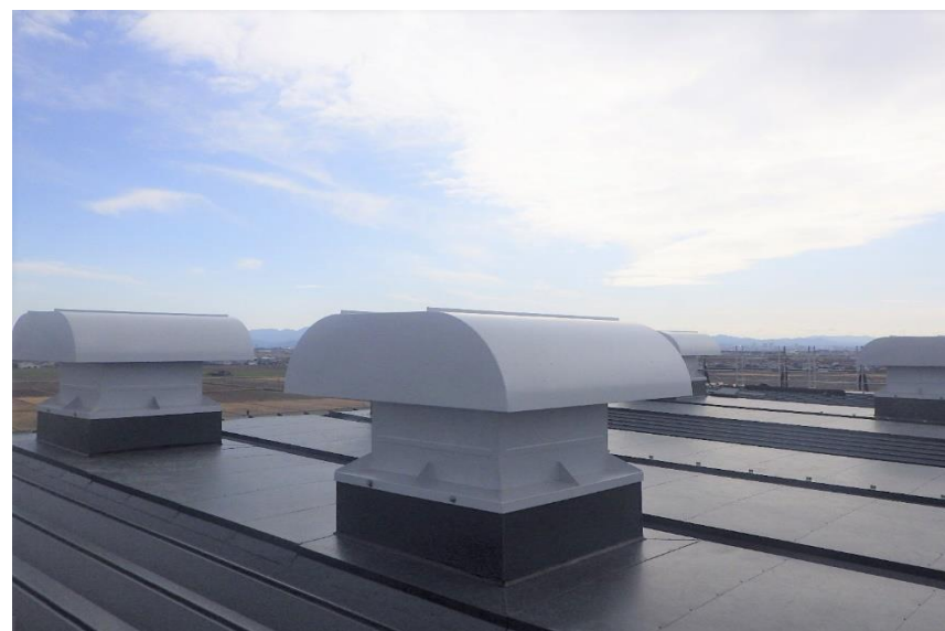
(4) 熱回収施設：炉室屋根ベンチレーター据付
