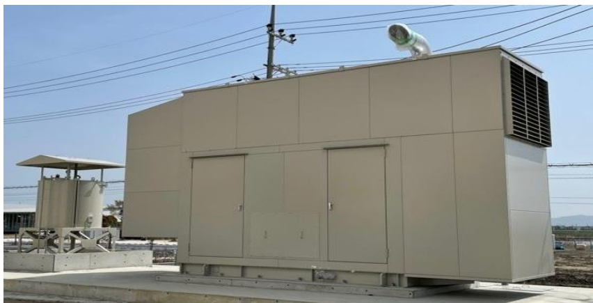
(7) 屋外：非常用発電機据付
