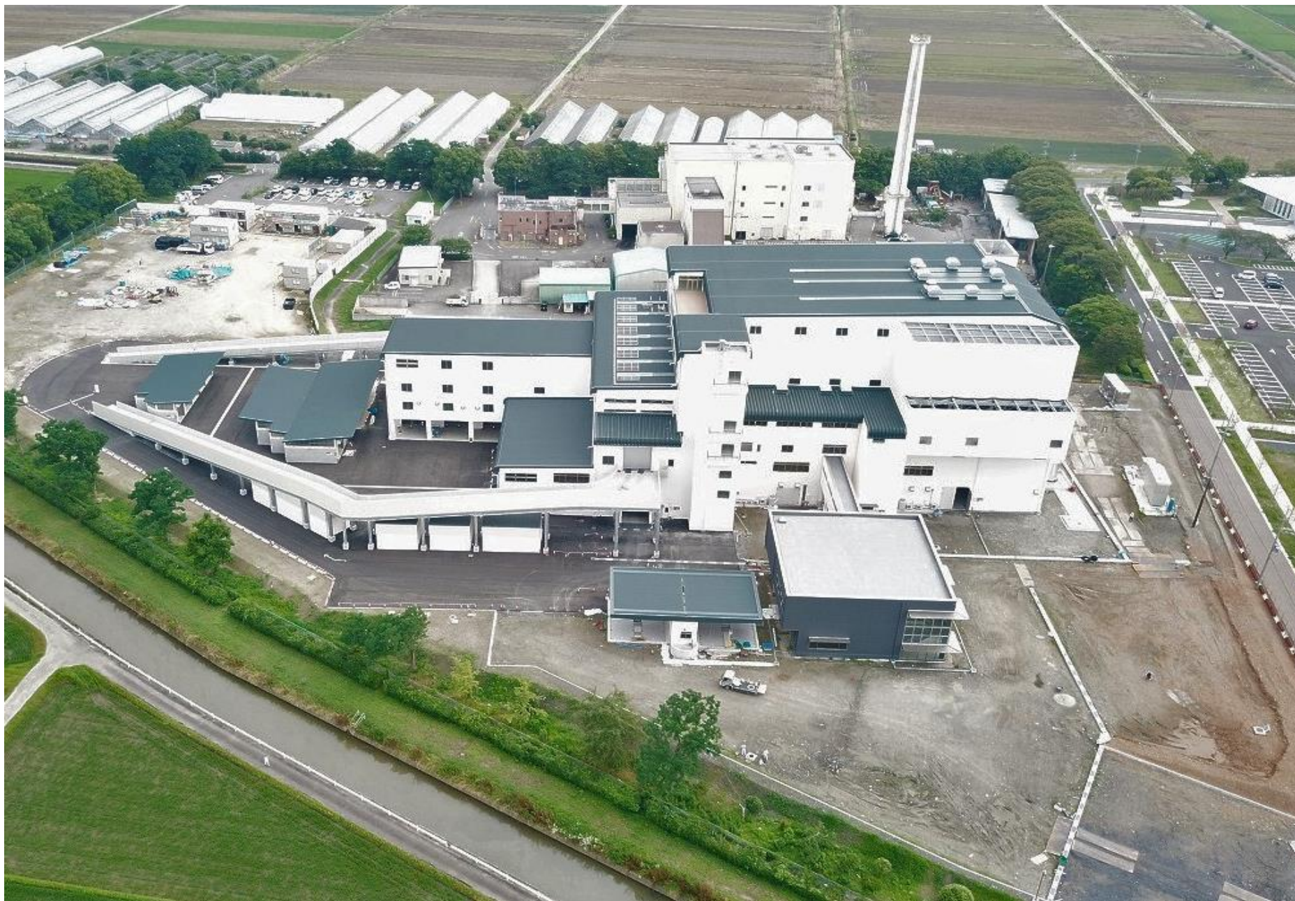
令和3年6月（2021年6月）の工事状況 6月30日撮影
