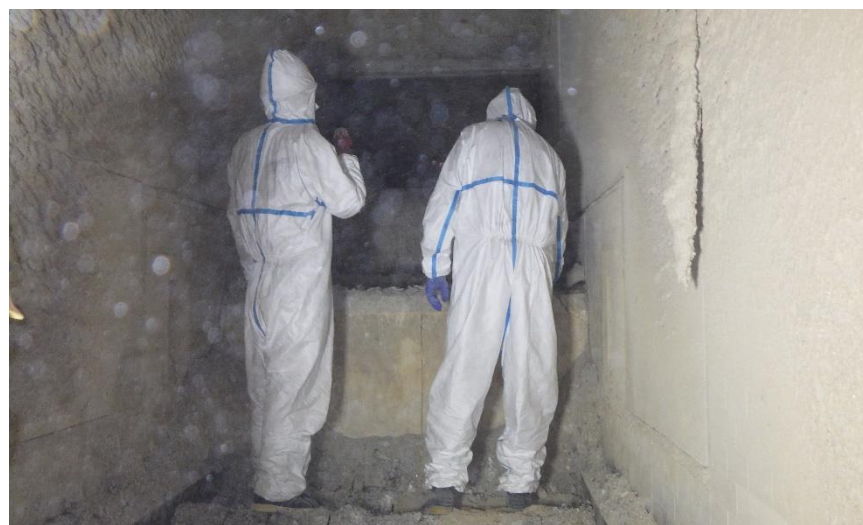
(4) 熱回収施設：試運転（焼却炉内点検）
