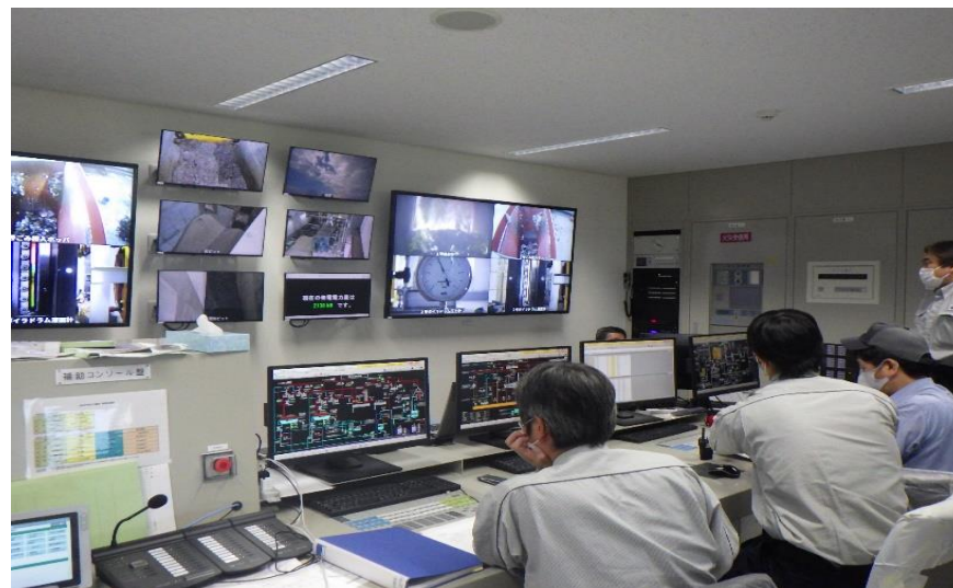
(2) 熱回収施設：試運転（中央制御室）
