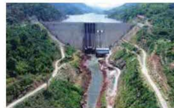
【水力】ナムニアップ1発電所
