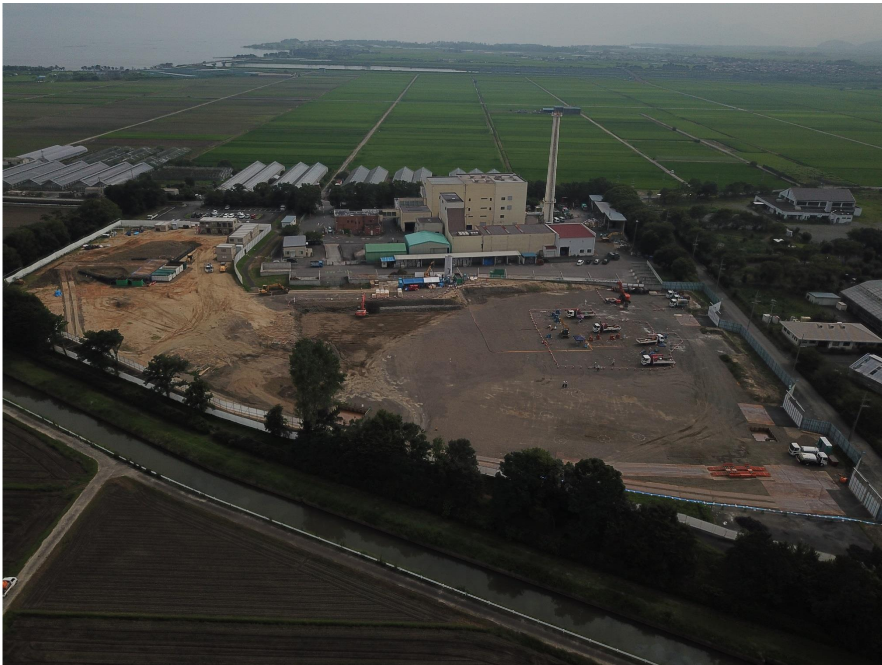
令和元年7月（2019年7月）の工事状況 7月18日撮影
