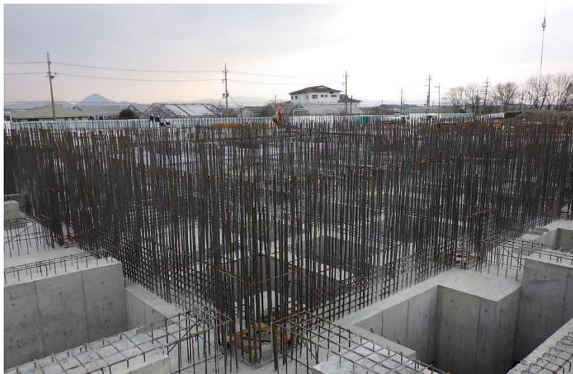
(4) リサイクル施設：基礎コンクリート打設
