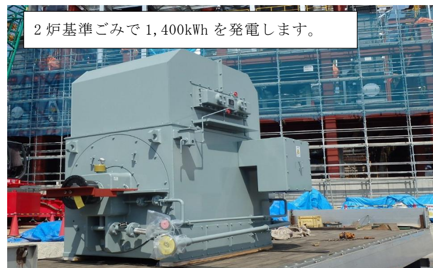
(8) 熱回収施設：タービン発電機搬入
