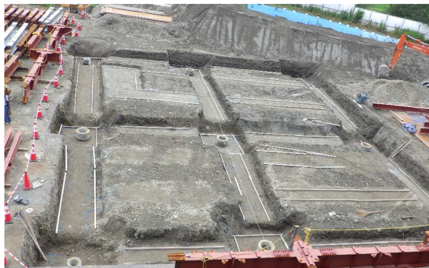
(4) 管理棟：基礎工事
