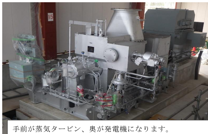
(8) 熱回収施設：蒸気タービン発電機据付
