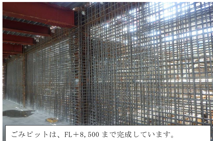
(3) 熱回収施設：ごみピット(3階部) 配筋工事
