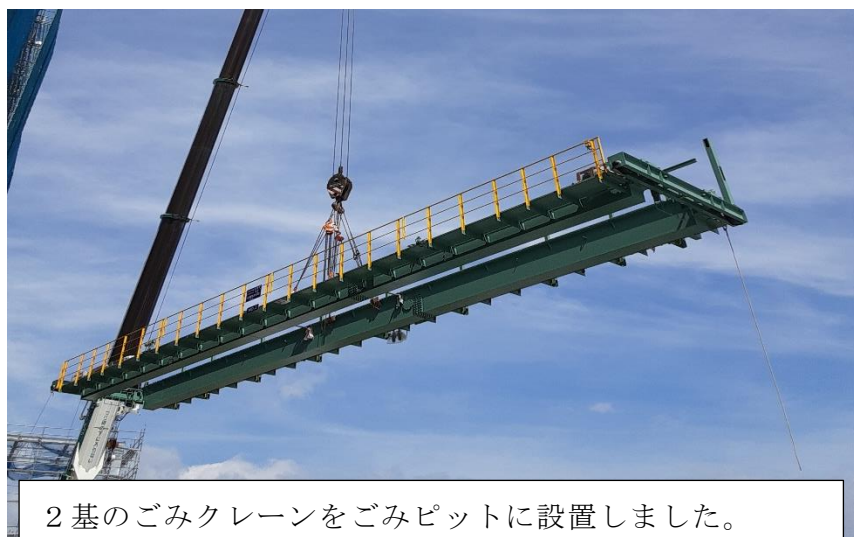
(7) 熱回収施設：ごみクレーン取込み
