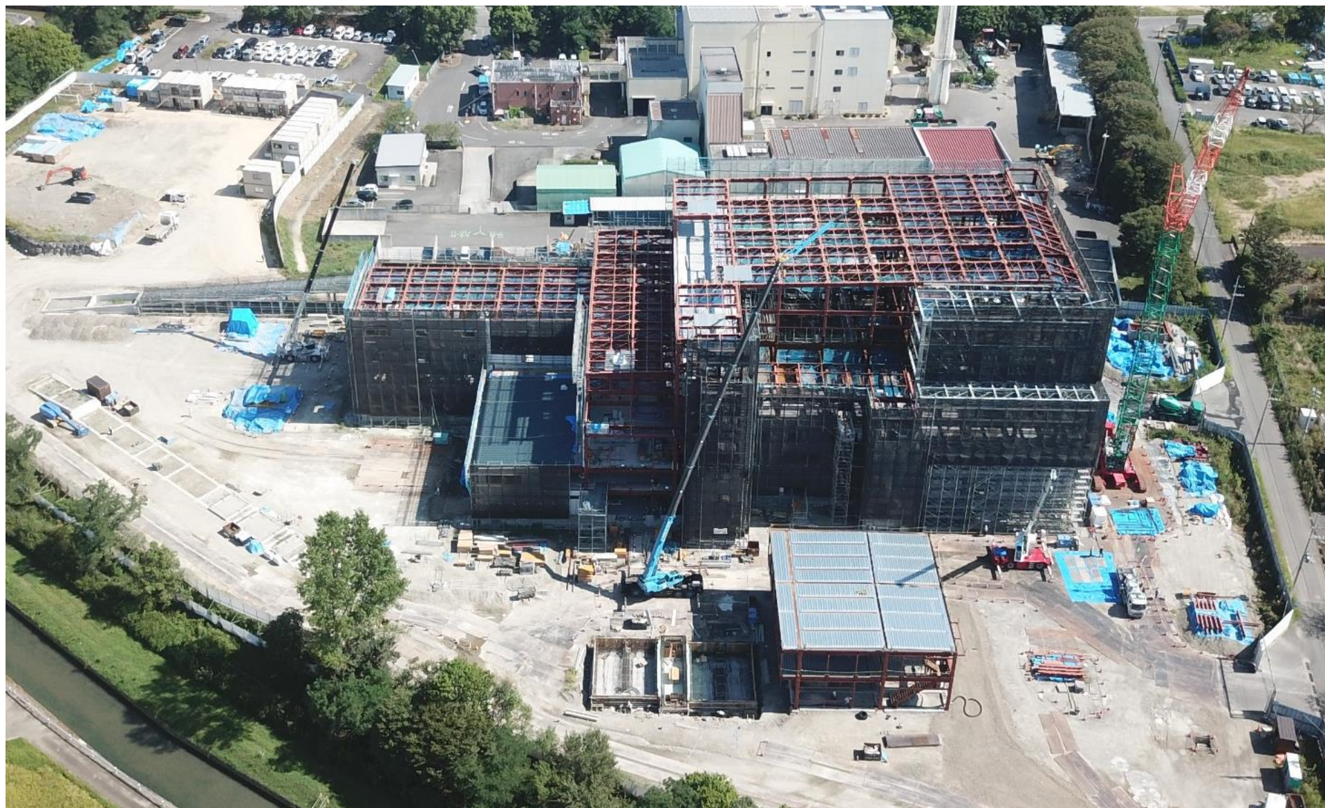
令和2年8月（2020年8月）の工事状況 8月31日撮影
