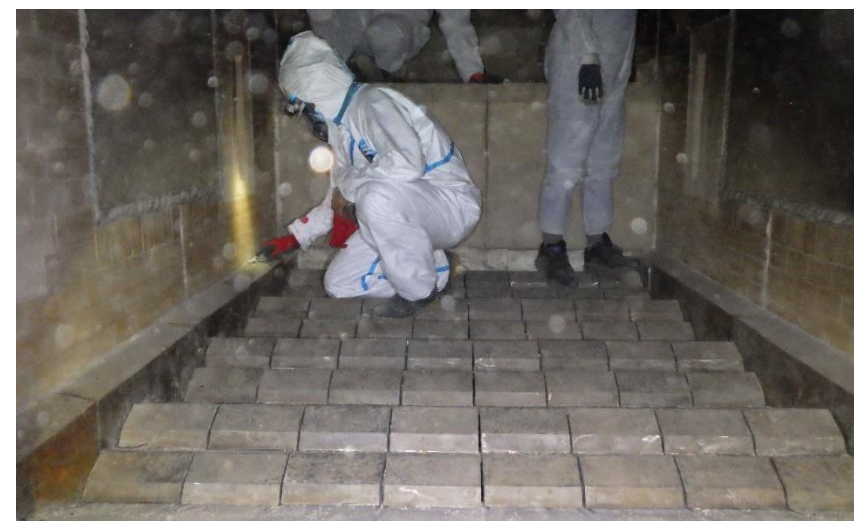
(4) 熱回収施設：乾燥焚き後の炉内点検
