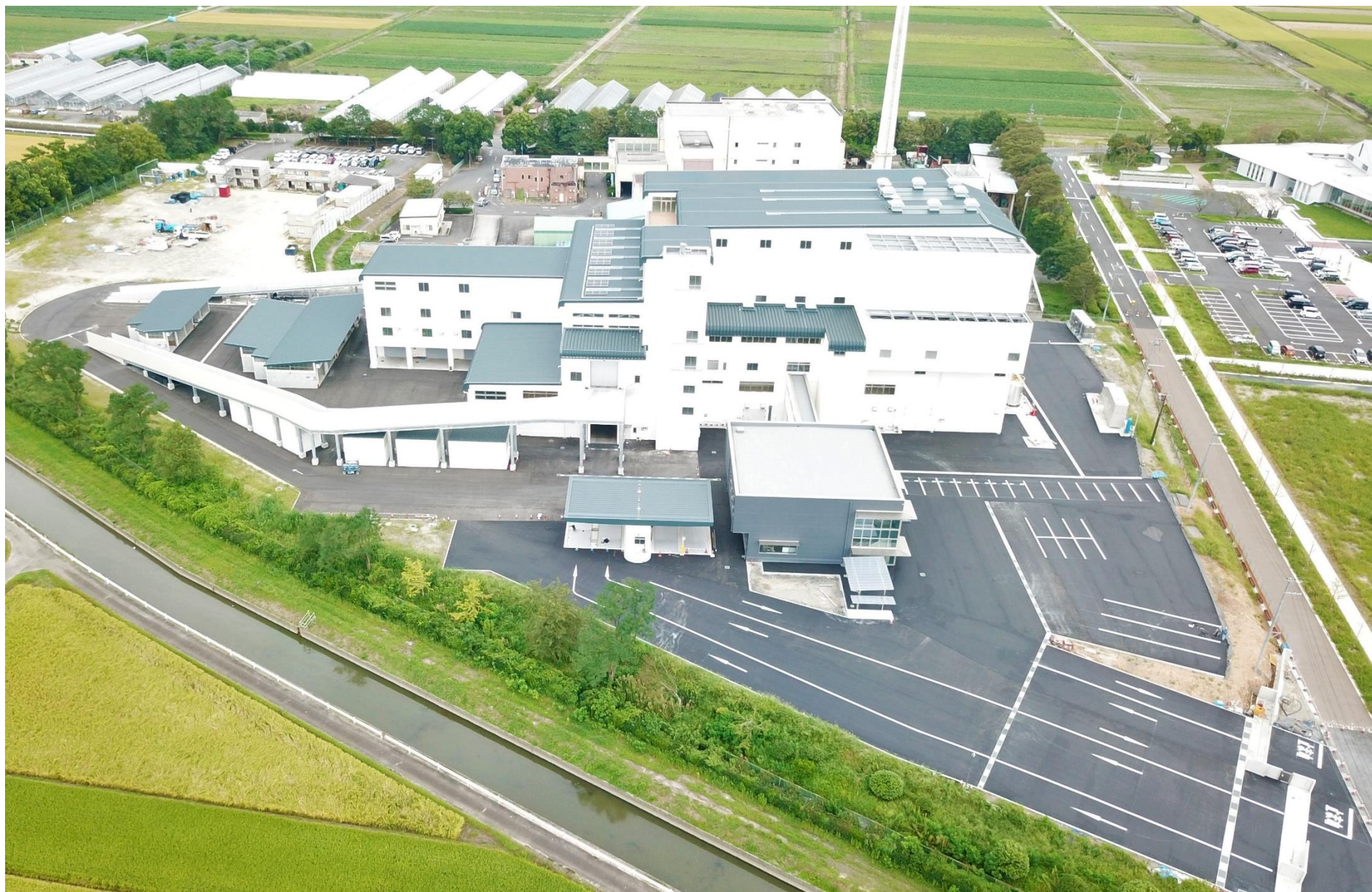
令和3年8月（2021年8月）の工事状況 8月31日撮影
