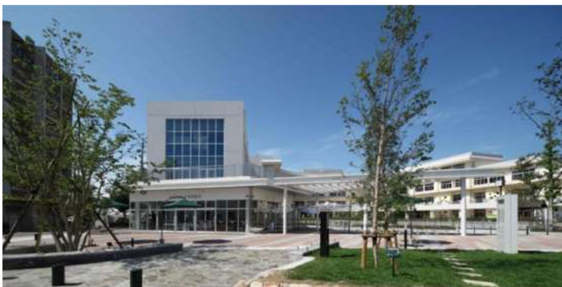
守山市中心市街地活性化交流プラザ（愛称：あまが池プラザ）
