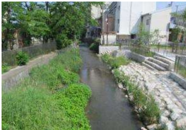
■ あまが池親水緑地整備
