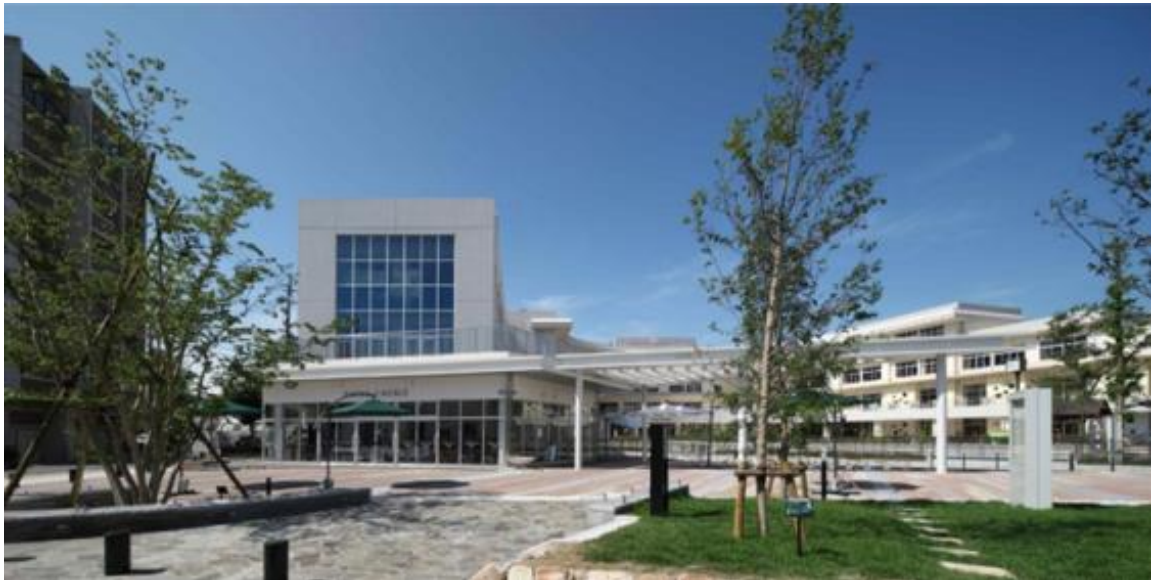
守山市中心市街地活性化交流プラザ（愛称：あまが池プラザ）
