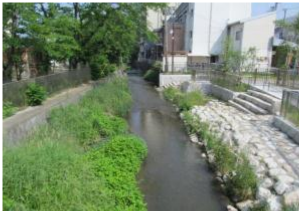
■ あまが池親水緑地整備
