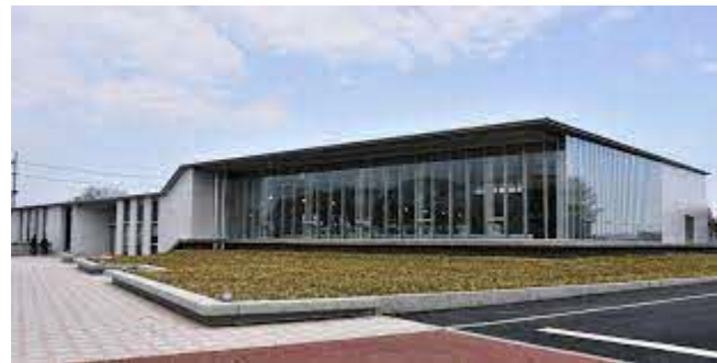
もりやまエコパーク交流拠点施設 (R2竣工) : エネルギー融通
