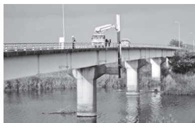
天満大橋の橋梁点検状況(守山市小浜町地先)
