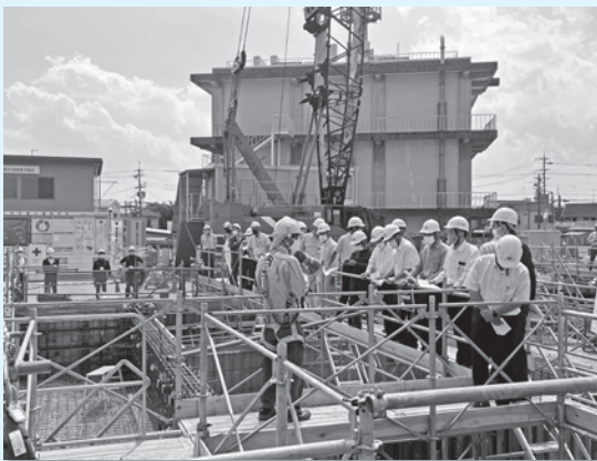
6月3日(基礎工事)
