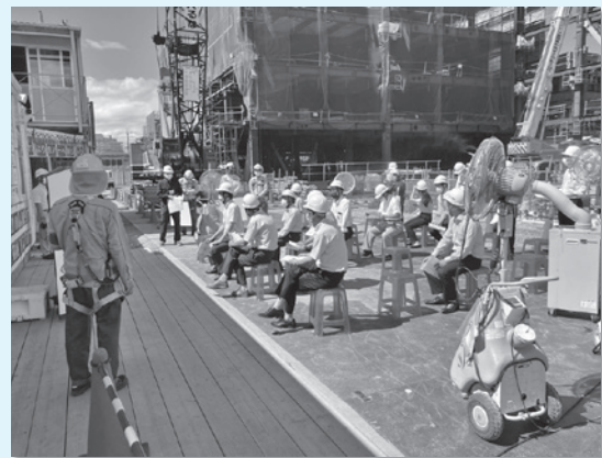
9月2日(鉄骨建方工事)
