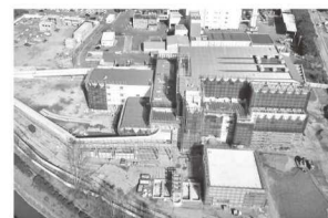
令和3年1月末の工事状況
