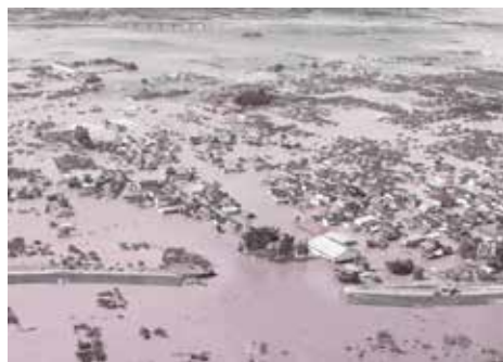
令和元年台風第19号の豪雨被害 (長野県千曲川堤防決壊)
