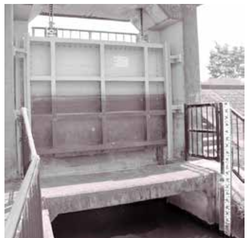
赤野井の樋門の様子
