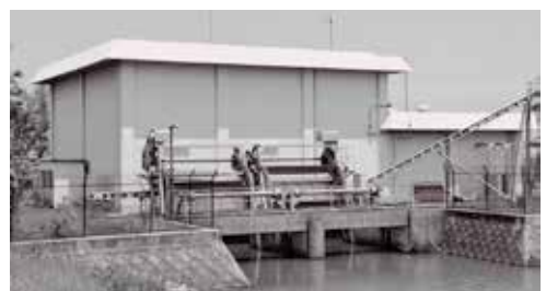
赤野井排水機場
