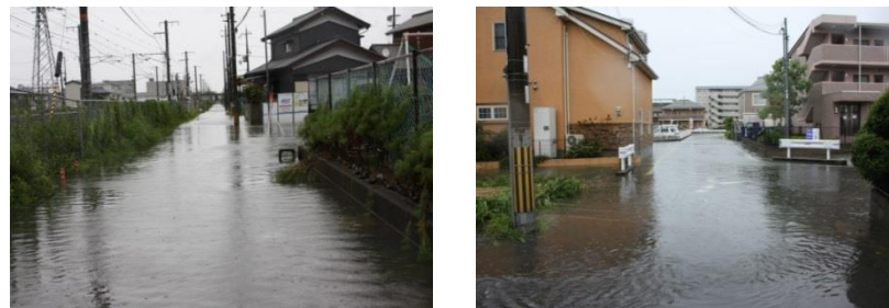
H25.9台風18号時状況写真
