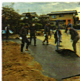
防草シートを敷いて土をかける
